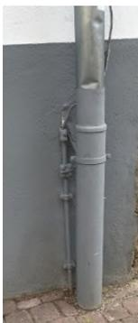
Die Erdungsanlage dient dazu, den Blitzstrom in der Erde bzw. dem Gebäudefundament zu verteilen und unschädlich zu machen. Naturgemäß können Sie nicht sehen, ob eine Erdungsanlage vorhanden ist. Lediglich der Übergang von Ableitung zu Erdungsanlage ist sichtbar. Dort, wo die Ableitung in Bodennähe kommt, sind Erdführungen aus Stahl befestigt.
