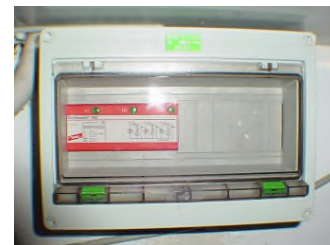
Nachträglich eingebauter Überspannungsableiter der Fa. DEHN in einen Isolierstoffkasten neben der Hauptverteilung
